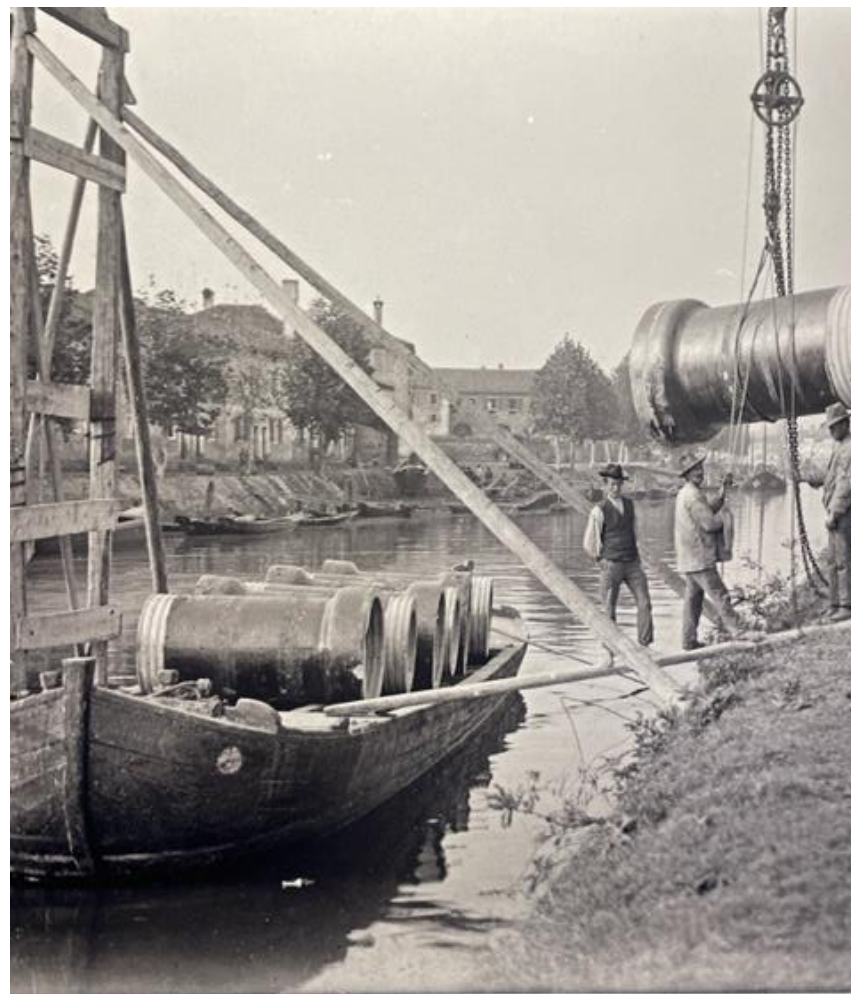
estrate, canal Salso, carico di tratti del tubo DN 1000, 1913-15 (archivio Veritas)
