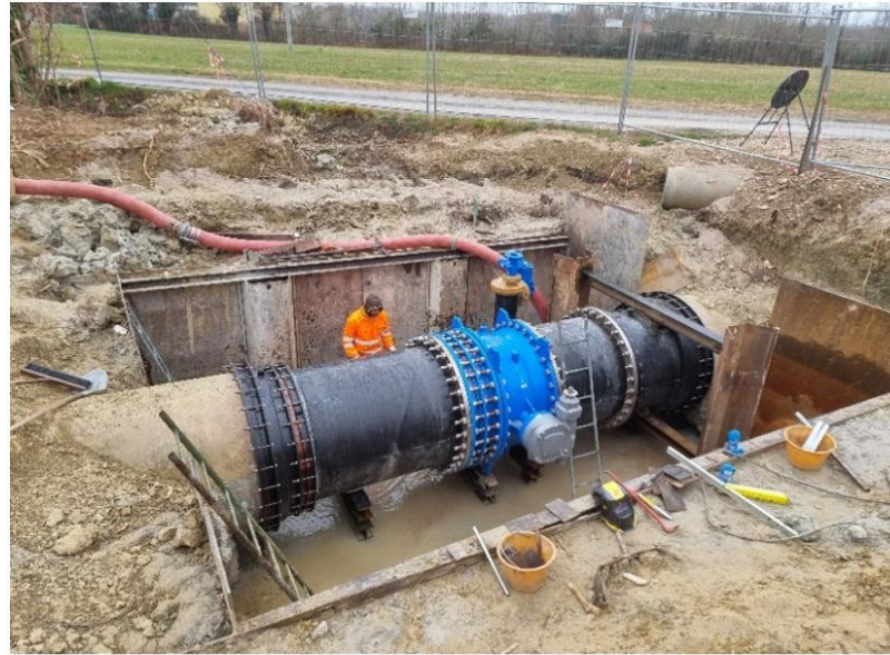
Foto 3: riconnessione della tubazione dopo il relining CIPP.
