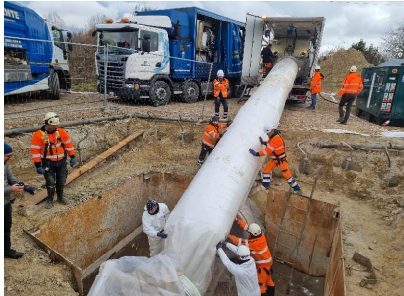
Foto 2: inserimento a inversione e catalisi a vapore (guaina B).
