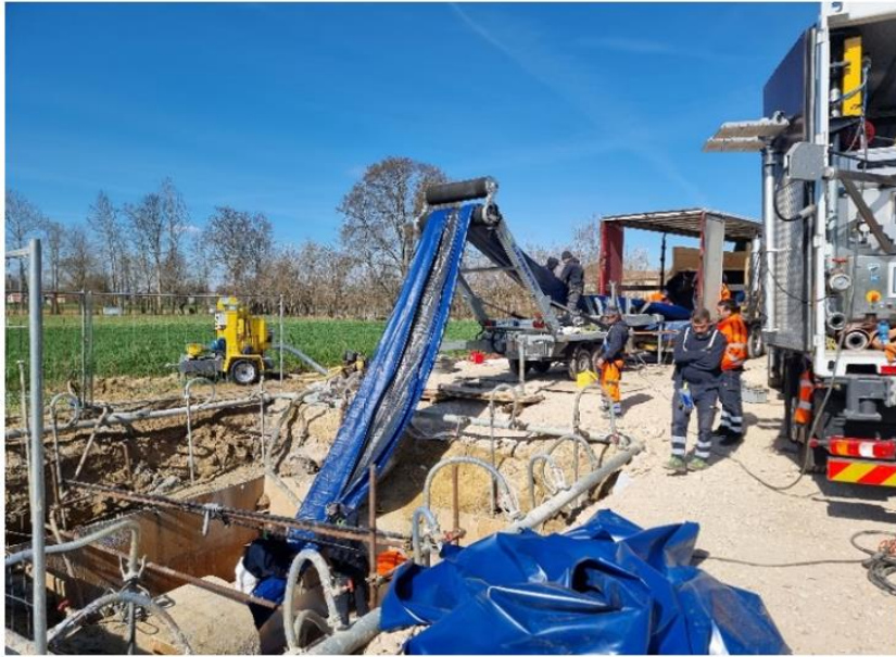
Foto 1: inserimento mediante traino e catalisi a raggi UV (guaina A).
